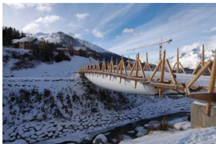
Tensairity-Skibrücke in Lanslevillard, Frankreich [4]
