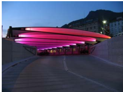
Parkhausüberdachung in Montreux, Schweiz [2]
