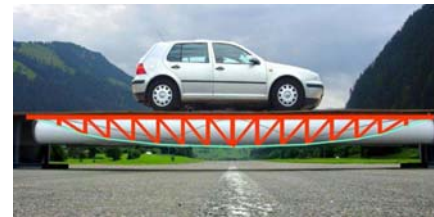
Demonstrationsbrücke mit eingezeichneter Fachwerkkanalogie [5]
