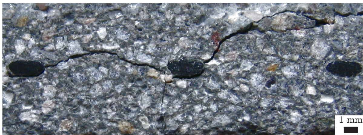
Abbildung 1.2: Rissbildung in textilverstärktem Beton
