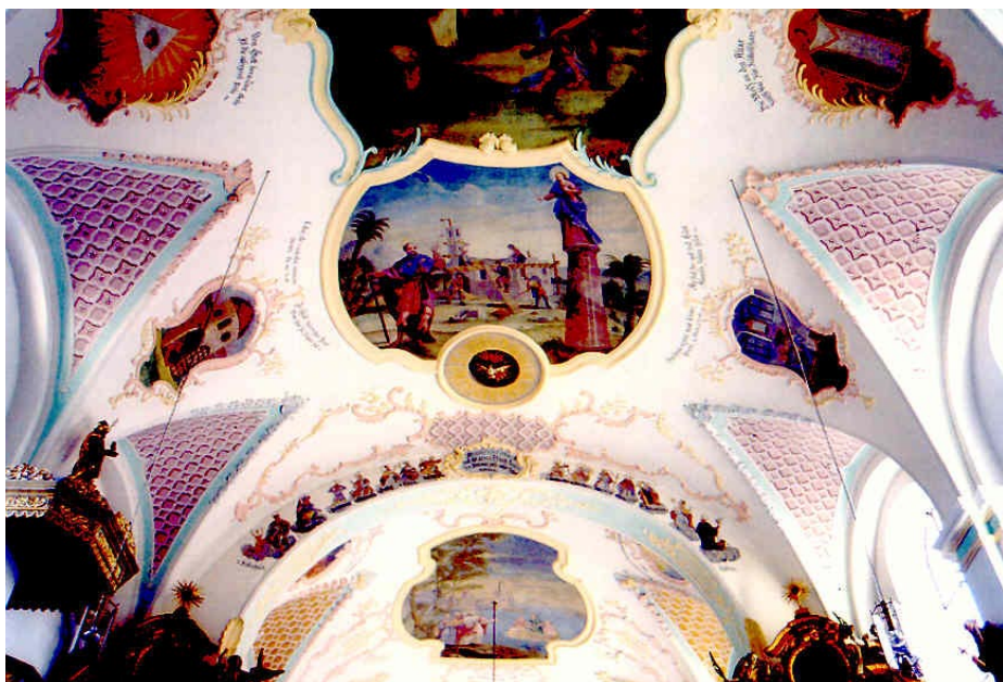
Bild 1.1: Tonnengewölbe mit Stichkappen - Untersicht der Einwölbung über dem Langhaus der St. Jakob Kirche in Willing / Bayern. Foto: Verfasser, 2002
