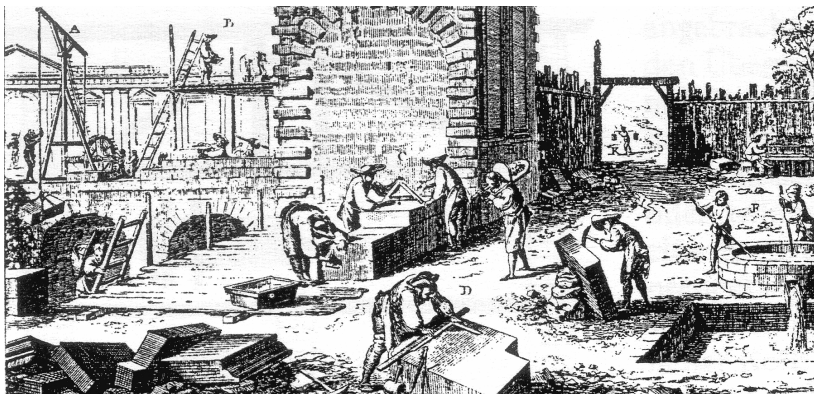
Bild 3.3: Baustelle aus dem 18. Jahrhundert. Rechts im Bild: Das Löschen von Kalk. Aus Eckert, 1993
