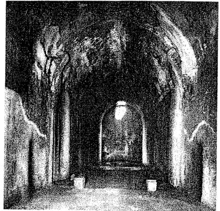
Abb.6.2.7: Tonnengewölbe aus Gußmauerwerk im 'Goldenen Haus des Nero', 68 n.Chr., aus Poulsen [242].
