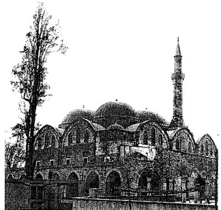
Abb.7.1.24: Piyale Paşa Camii von Sinan als Beispiel einer Konstruktion mit gereihten Pendentivkuppeln, aus Hotz [212].
