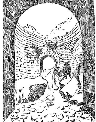
Abb.7.1.5: Kuppelansatz eines Felsengrabes bei Dira-Abu'n-Naga/Theben (20. Dynastie, um 1500 v.Chr.) nach Creswell [189].
